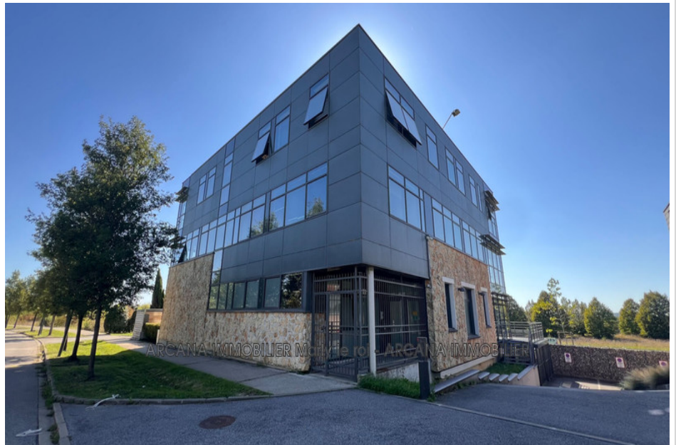
House 1516 LE CHESNAY ROCQUENCOURT
